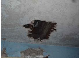
Fig. 95: Missing timber window apron.
